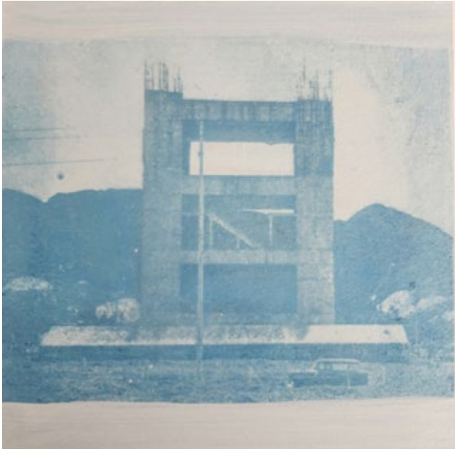
En obra B2
